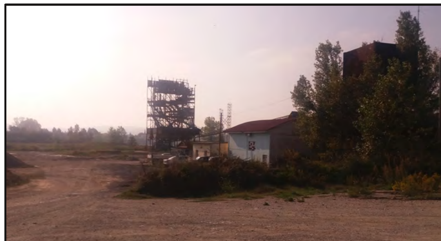
Foto 1 - edifici e strutture dell'impianto di lavorazione inerti CSB dismesso. L'area rientra nel piano di riqualificazione definito nel POC1.
