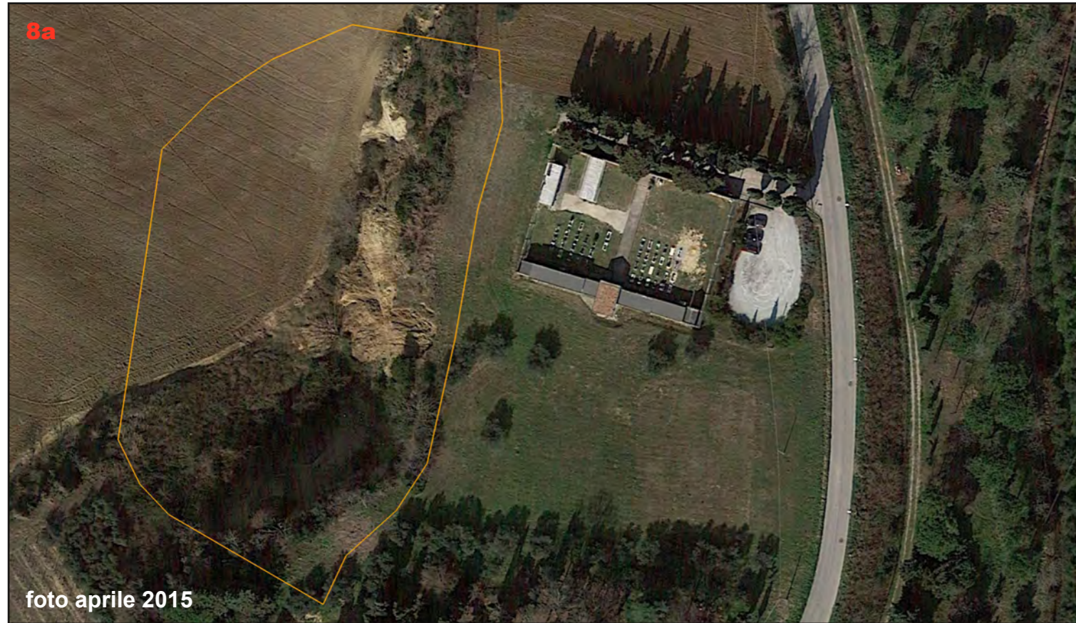
Foto 1 - foto aerea dell'aprile 2015 dell'area Montalbano a; si evidenzia la presenza di alcuni smottamenti sulla scarpata di ex-cava, uno dei quali visibile ancora oggi.
