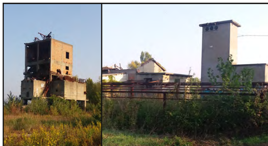
Foto 1 - edifici abbandonati della passata attività di lavorazione inerti. Sulla sinistra il corpo centrale dell'impianto di frantumazione, sulla destra la cabina elettrica e altri edifici in parte crollati. Gli edifici risultano fortemente incongrui con il contesto paesaggistico ed ambientale locale. La sistemazione finale dovrà prevederne lo smantellamento.
