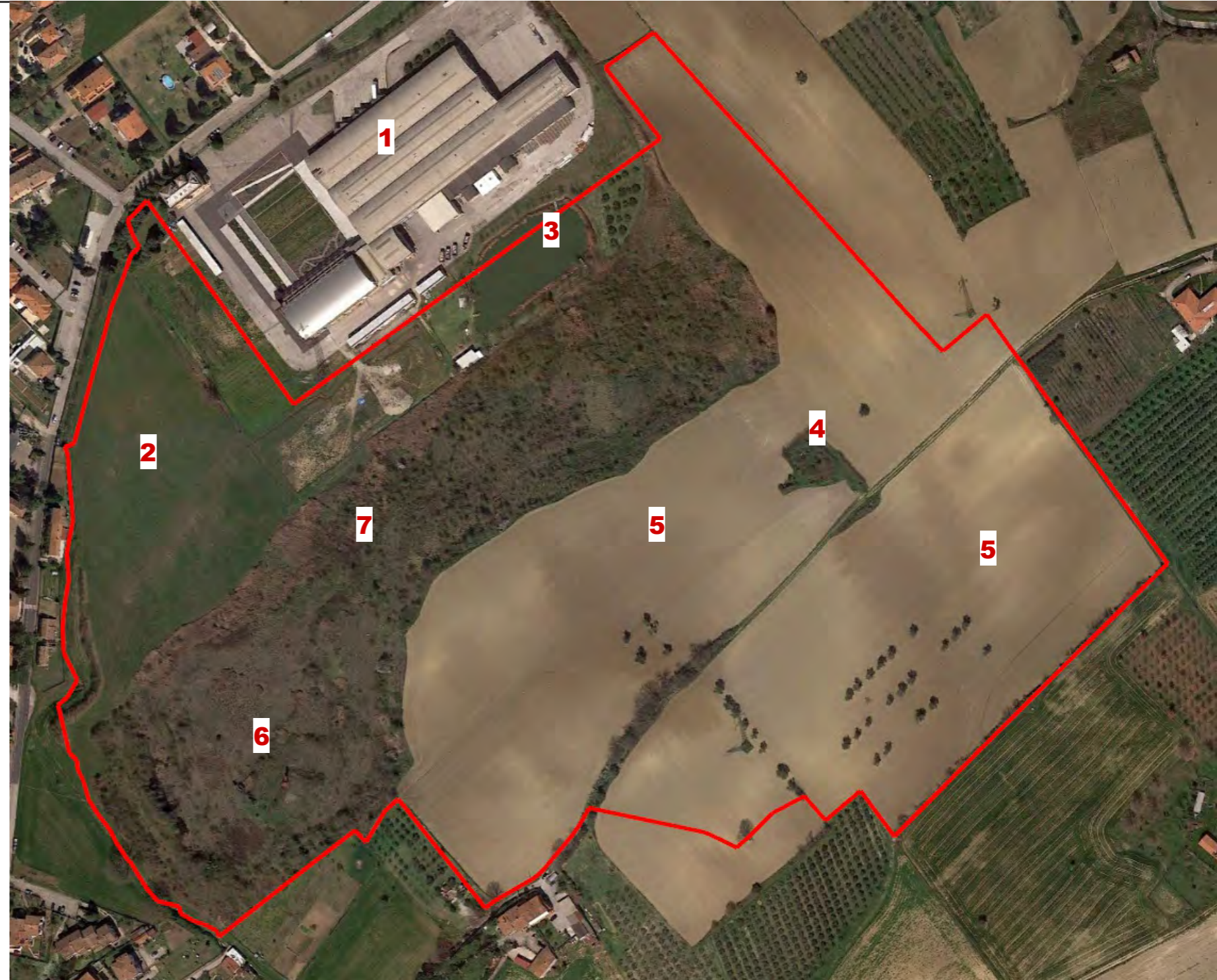
Foto 3 - Stato di fatto - immagine dell'aprile 2018.
