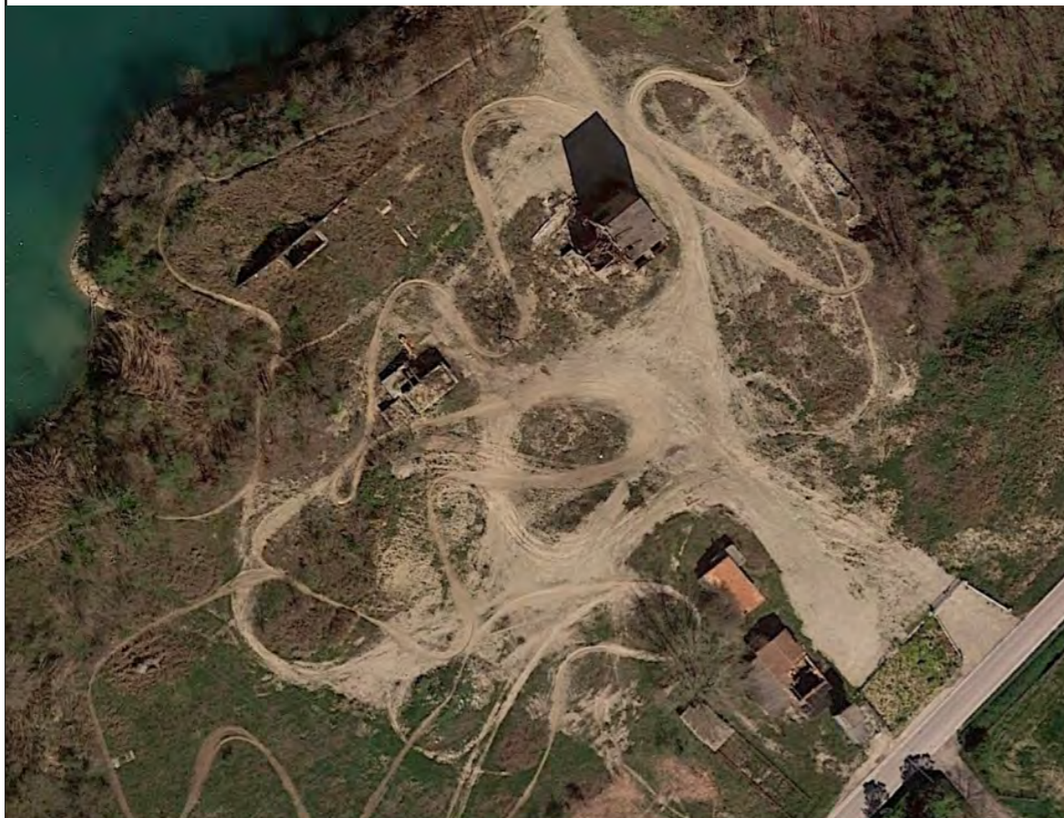
Foto 2 - particolare della zona ex impianti di lavorazione. Per l'area dovranno essere pianificati interventi di riqualificazione con smantellamento degli elementi incongrui con il contesto paesaggistico ed ambientale locale. La zona presenta un elevato degrado dei caratteri identitari.
