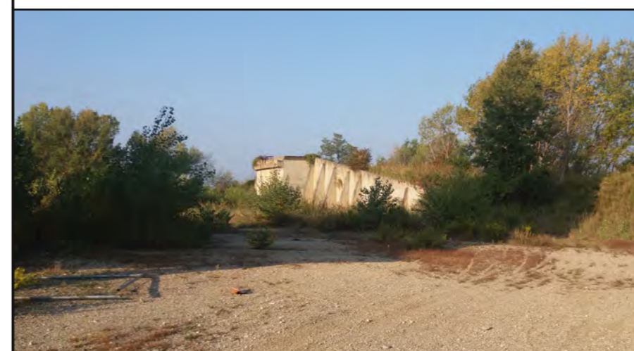
Foto 6 - muro residuale della rampa di carico dell'impianto abbandonato. Il contesto è caratterizzato dalla presenza di ampie porzioni rinaturalizzate per le quali si ritiene necessaria una valutazione botanico-vegetazionale di dettaglio a compendio della progettazione di interventi di sistemazione morfologica e funzionale. La sistemazione finale dovrà prevederne lo smantellamento.
