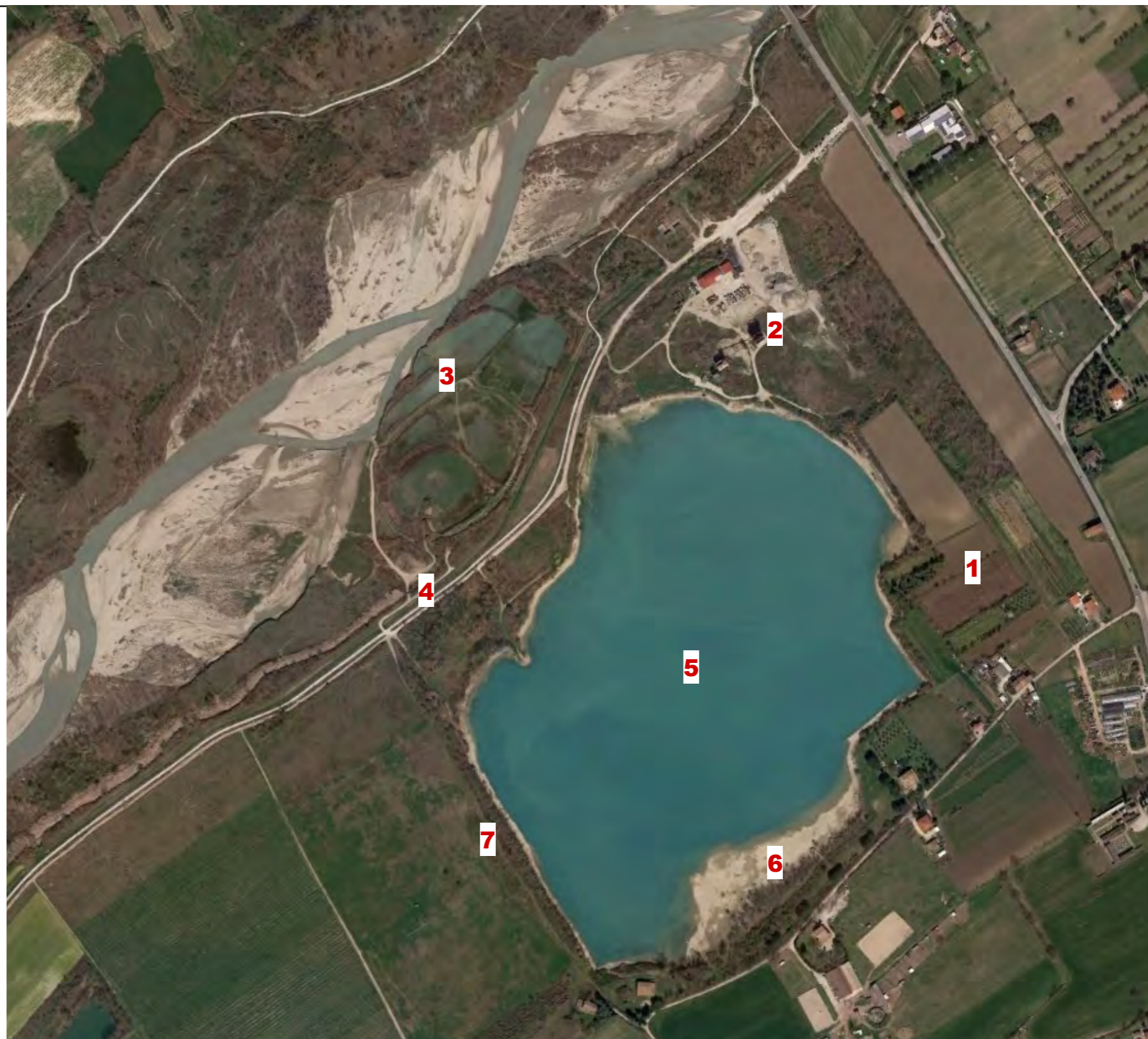
Foto 3 - Stato di fatto - immagine dell'aprile 2018.
