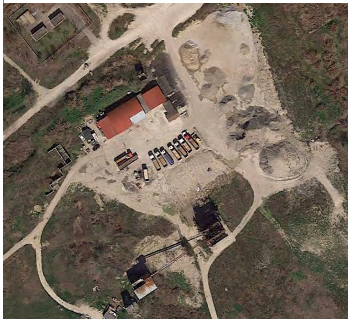
Foto 2 - particolare della zona ex impianti di lavorazione. Per l'area dovranno essere pianificati interventi di riqualificazione con smantellamento degli elementi incongrui con il contesto paesaggistico ed ambientale locale. La zona presenta un elevato degrado dei caratteri identitari, con attività in corso fortemente impattanti sul contesto ambientale locale.
